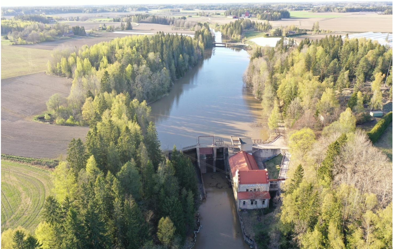
Juntolan voimalaitos ja patoallas 2020-luvulla. Kuva Oskari Summanen.
