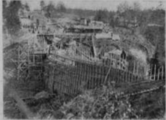
Juntolan pato rakenteilla.
