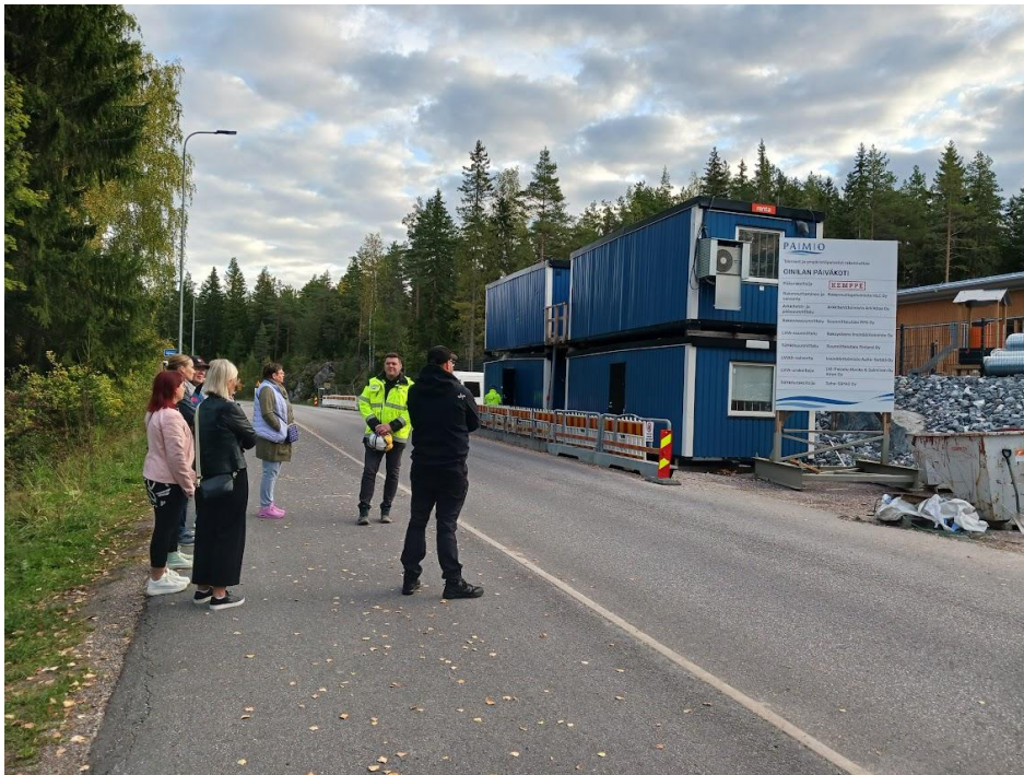
Kuva 1. Tarkastuslautakunta Oinilan päiväkodin rakennustyömaalla.
