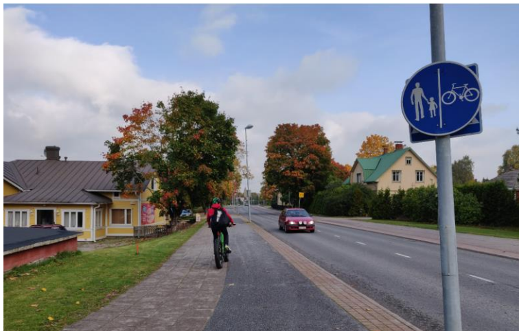
Erottelu toimii puutteellisesti, jos pyörätie jää liian kapeaksi. Erottelussa tulee myös välttää tasajakoa 50/50 (Vistantie)
