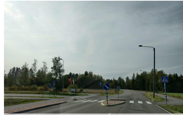
Yhdistetty pyörätie ja jalkakäytävä vaihtaa puolta Valkojantiellä kahdesti, mistä heikentää sujuvuutta luoden kaksi tarpeetonta risteämää autoliikenteen kanssa.
