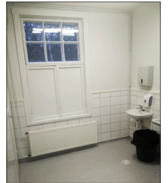
Poikien vessa kesken ja jälkeen remontin
