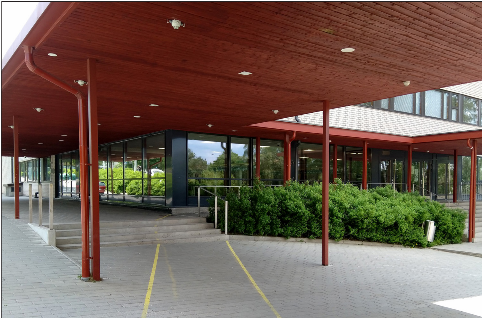
Vistan koulun pääovista pääsee koulun aulaan esteettömästi liuskaa (vasemmalla) hyödyntämällä.
